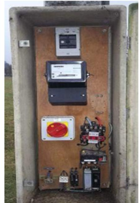
Les photos : Exemple de coffret électrique à sécuriser et luminaires mazda et boule à remplacer en priorité. Ci-dessous, nouveaux modèles type routier et résidentiel.
