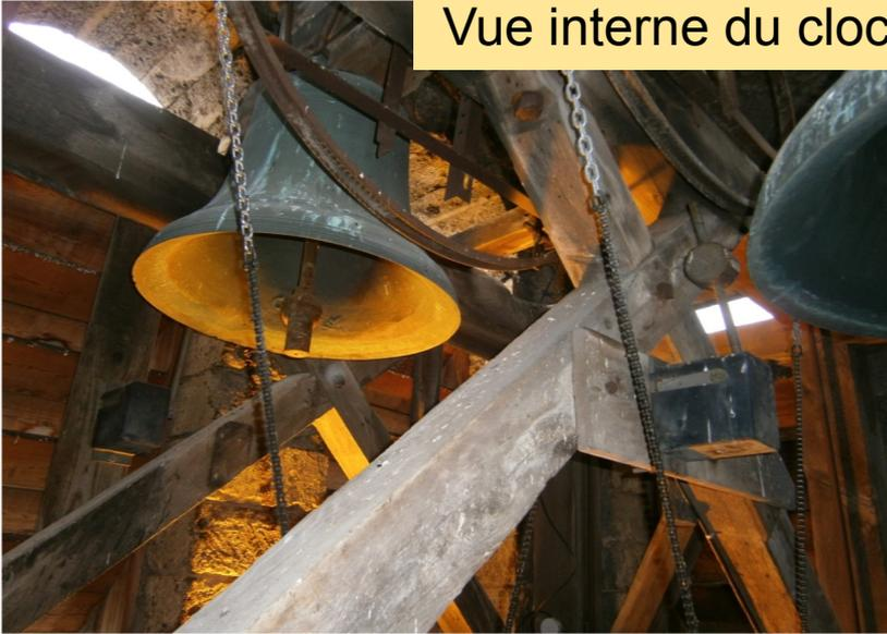
En décembre, l'armoire de commande des cloches de l'église a été remplacée suite à des problèmes électriques. En même temps, le battant de la cloche principale a été changé. Il était usé, le point de frappe de la cloche n'était pas correct et risquait de la fêler. L'ensemble de ces travaux a été réalisé par une entreprise spécialisée de Haute-Savoie pour un montant de 3700 € TTC.
